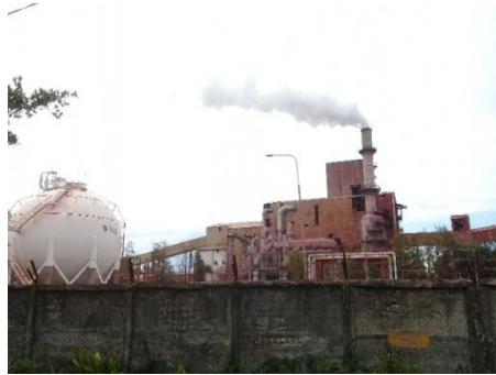
Gambar 1.1 Pabrik di daerah Gresik Sumber: (Dokumentasi pribadi.2020)
