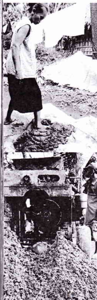
campuran tanah dengan cara tradisional n dengan mesin giling
