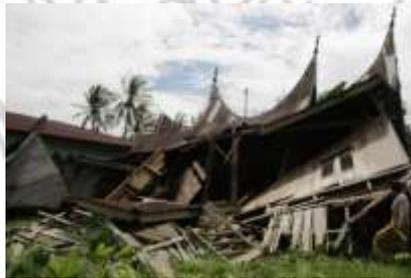
Gambar 3. Rumah gadang yang roboh di Daerah Pedalaman Minangkabau
