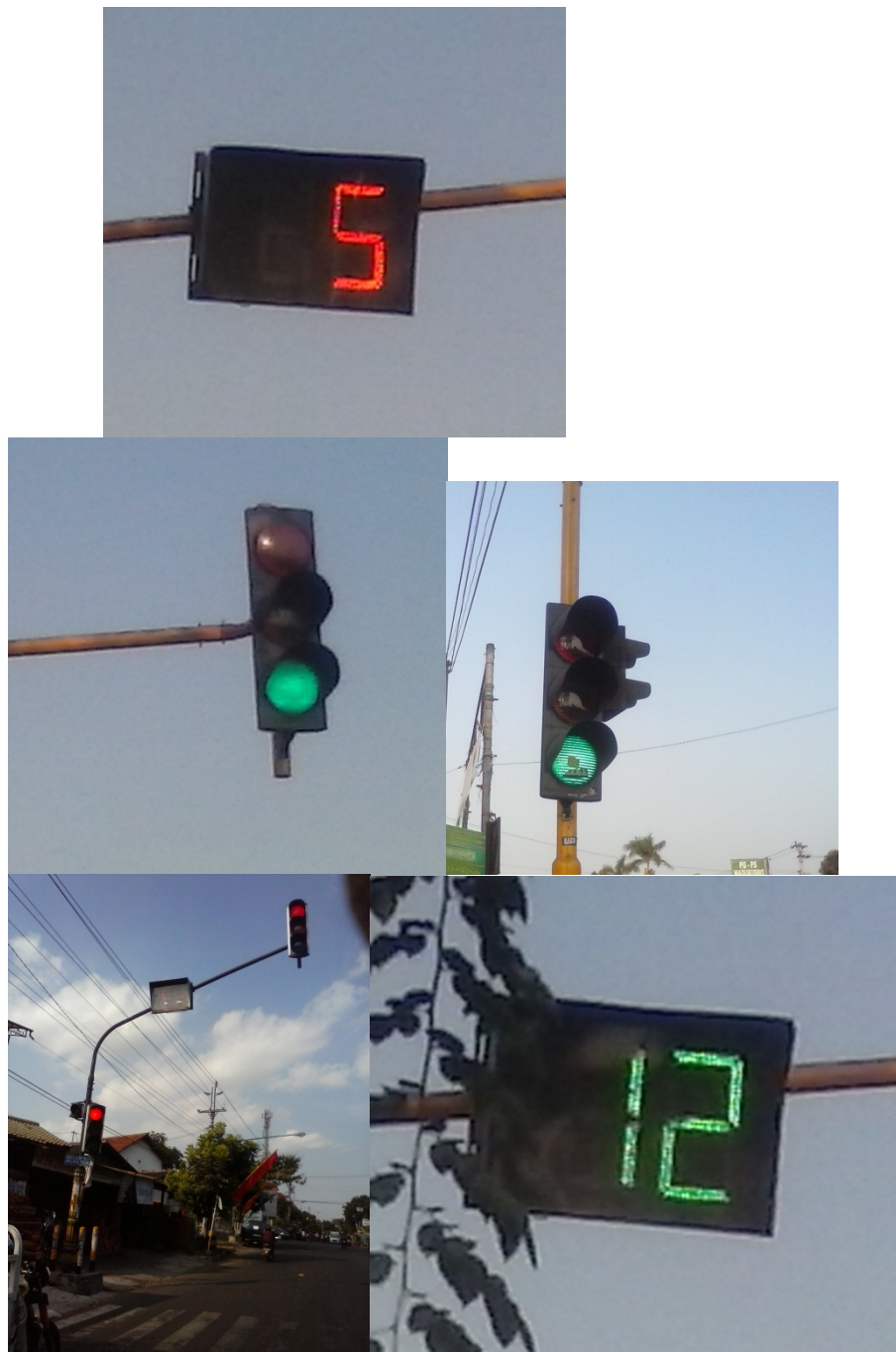
Gambar 5. Fenomena dilapangan yang memicu munculnya ide penciptaan ( Foto : Penulis)
