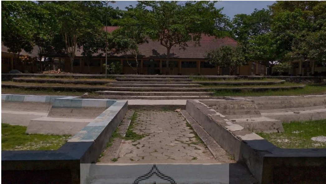
Gambar 2.27 Existing Tampak Depan Gedung 5
