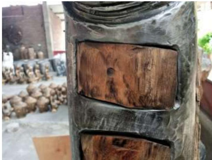
Gambar 22. Contoh pemasangan kayu dengan logam yang rapat. (Foto: Ranu Marfa, 2020).
