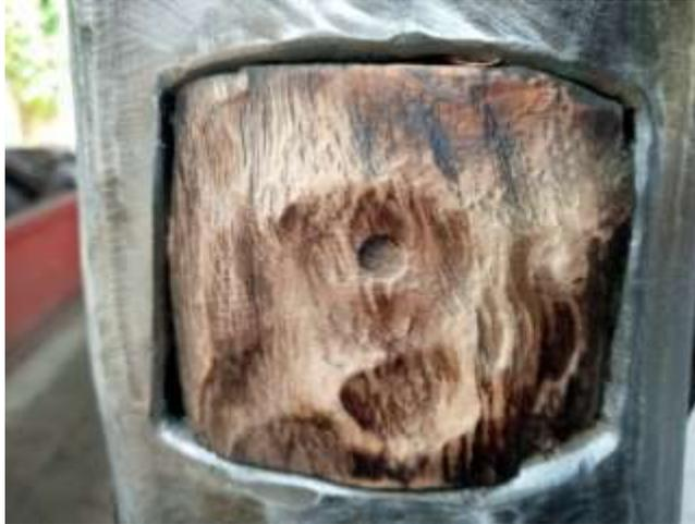
Gambar 23. Contoh penutupan dowel di kayu sehingga warna baut tersamarkan. (Foto: Ranu Marfa, 2020).
