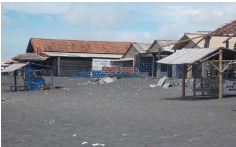
Gambar. 2 Bangunan penduduk yang hancur akibat erosi pantai (Foto : Arbain R, 2013).
