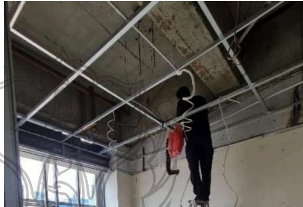
Gambar 2.39. Rangka Plafon Kantor
