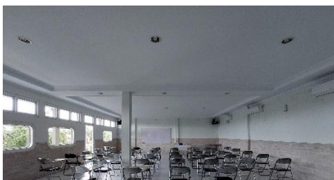
Gambar 2.30 Plafon Gypsum (Sumber: Data Pribadi)
