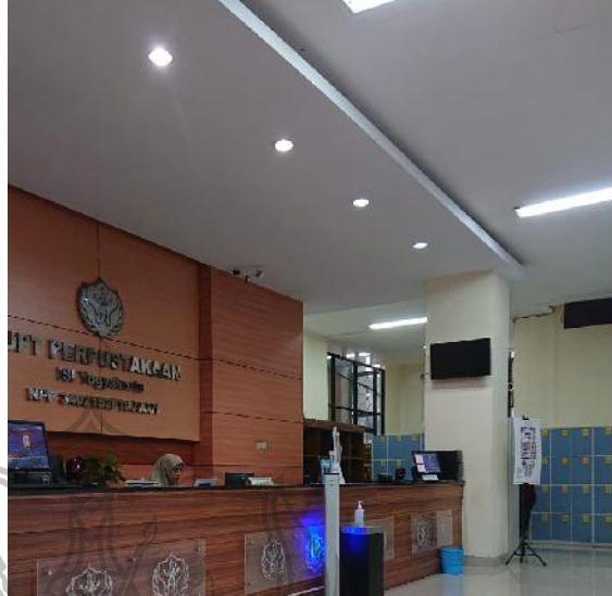
Gambar 2.17 Plafon Perpustakaan ISI Yogyakarta (Sumber: Setyawan H. R., 2024)
