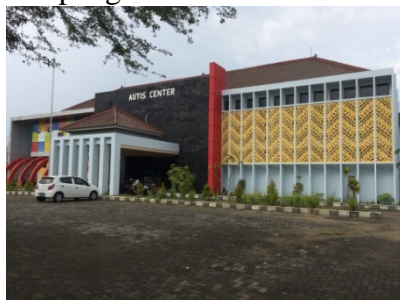
Gambar 2. Fasad Bangunan (Sumber: Dokumentasi Pribadi, 2016)
