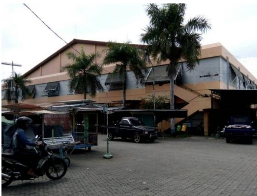
Gambar 1. Fasad Utara Bangunan (Sumber: Dokumentasi Pribadi, 2016)
