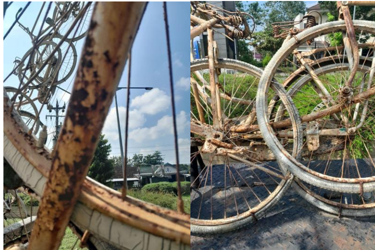
Gambar 3. karat yang tumbuh di permukaan Patung Infinity (Sumber: dokumentasi Penulis, foto diambil tanggal 30 juli 2023)
