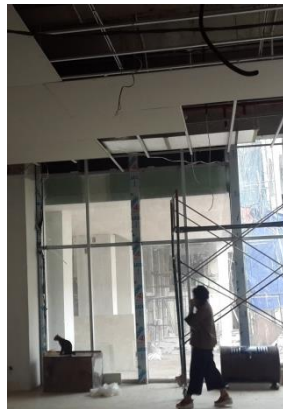
Gambar 4. Pemabangunan Area Lobby (Sumber: Dokumentasi pribadi, 2016)
