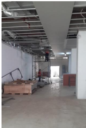
Gambar 3. Pembangunan Area Pamer (Sumber: Dokumentasi Pribadi, 2016)
