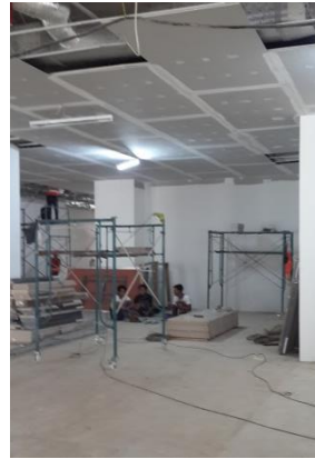
Gambar 2. Proses pembangunan Museum (Sumber: Dokumentasi pribadi, 2016)
