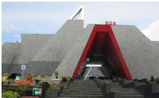
Gambar 1. Fasad Bangunan (Sumber: Dokumentasi Pribadi, 2017)
