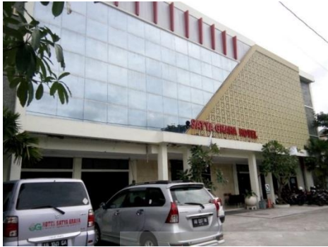
Foto 1. Fasad Hotel Satya Graha (sumber:dokumentasi penulis)
