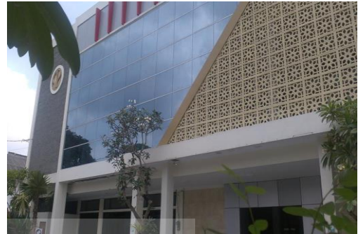
Foto 2. Fasad Hotel Satya Graha (sumber:dokumentasi penulis)
