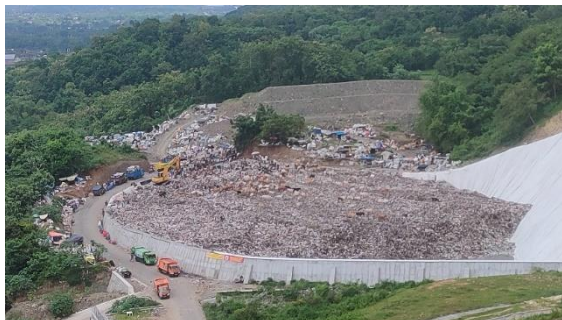
Gambar 3. 7 Mengunjungi TPA Piyungan Sumber : Dokumentasi Pribadi, 3 November 2023
