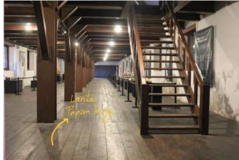
Gambar 2.19 Material lantai Area Pamer Lantai 2 (Sumber: Dokumentasi pribadi 2025)
