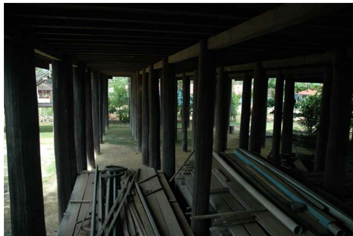
Tiang penyangga rumah betang , tinggi 3 meter di Tumbang Manggu 2013
