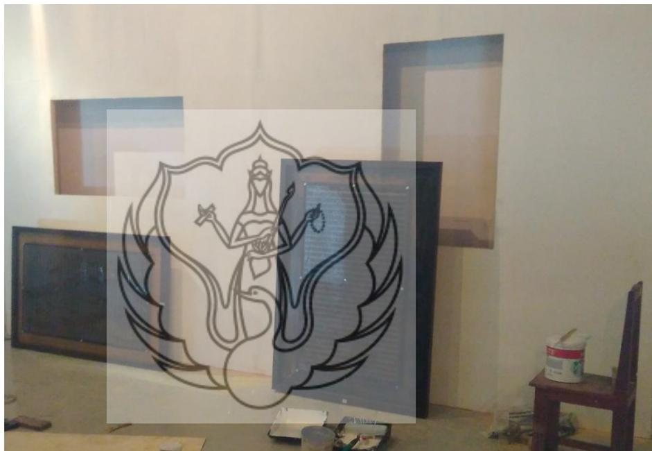
Gambar 63. Display karya yang memiliki Instalasi boks, dinding dirancang berlobang untuk menghilangkan Instalasi boks tersebut.
