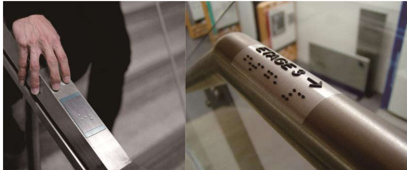
Gambar 13 Handrail dengan Huruf Braille
