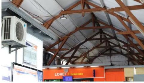
Gb.9. Plafon Stasiun Cirebon Prujakan (dokumen : perancang, 2017)
