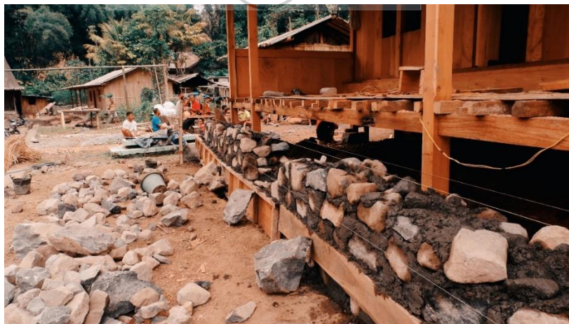
Gambar 22. Proses pemasangan penahan erosi (Sumber: Kadafi, 2018)
