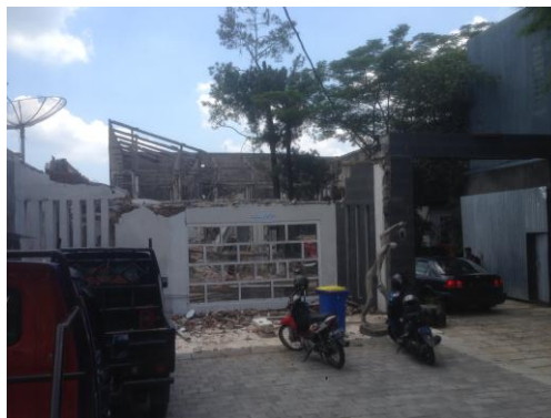
Gambar 7. Fasade Hotel Rama Shinta saat Proses Rekonstruksi
