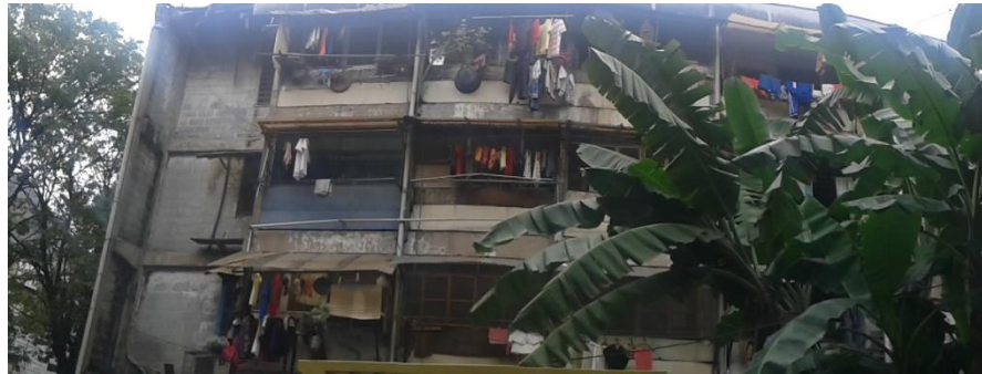
Gambar 2.11. Fasad Bagian belakang Rusunawa Blok A tampak tidak memiliki fasilitas jemur yang layak dan aman dari cuaca, polusi dan penyimpangan. Selain itu secara visual juga sudah tidak layak huni (Sumber: Achmad Fahjariharto, 2015)
