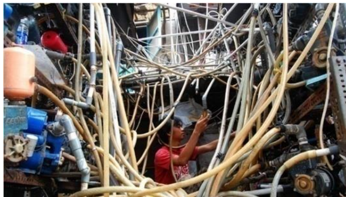
Gambar 2.19. Pipa-Pipa Saluran Air dikarenakan system saluran bangunan yang tidak baik (Sumber : Tempo,2014)
