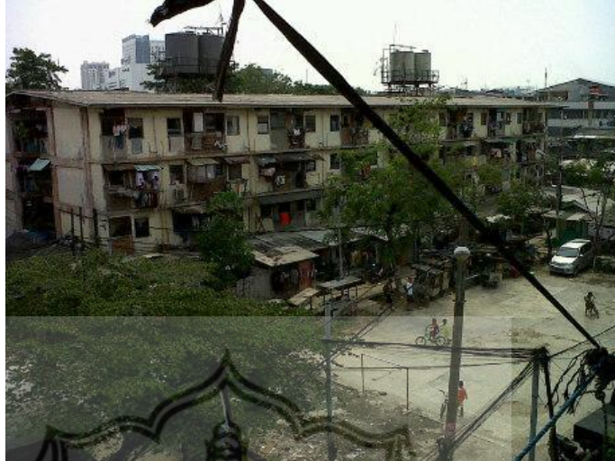
Gambar 2.3. Fasad Bangunan Existing Blok H (Sumber: Achmad Fahjariharto, 2015)
