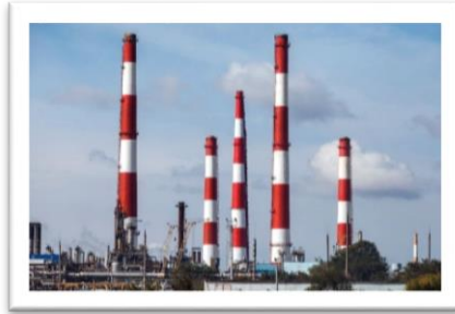
Gambar. 10. Cerobong Asap Pabrik Sumber: ( https://vseotrube.ru , 2018)
