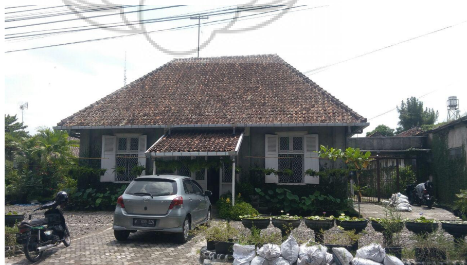
Gambar 5.17. Lokasi Set Rumah Beni di Kotabaru Yogyakarta
