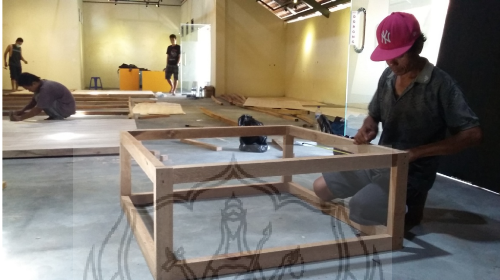
Pembuatan Rangka Untuk Box Stage LED
