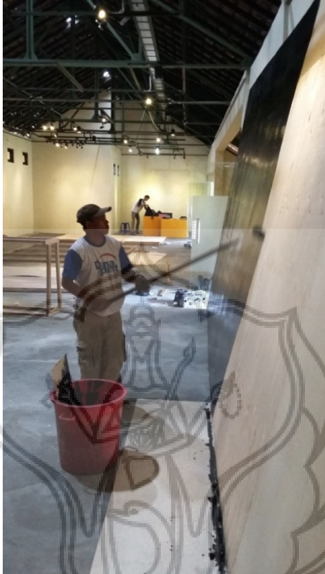
Proses pengecatan dinding ruang pameran
