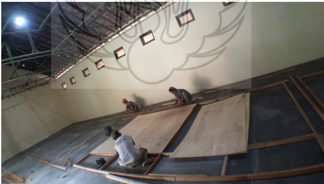
Proses Pemasangan Triplex
