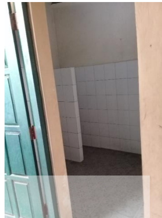
Foto 16. Toilet dan area wudhu
