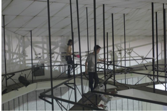
Gambar 46. Proses pemasangan lampu ( doc. Ody Art Studio 2019 )
