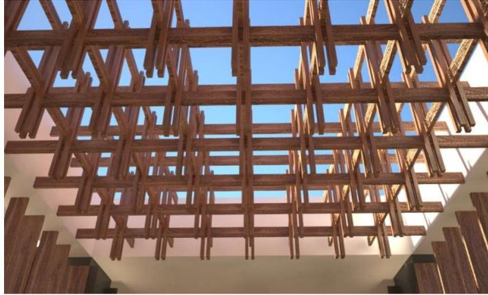
**Gambar 17. Atap pergola dengan konstruksi kayu *chidori***
