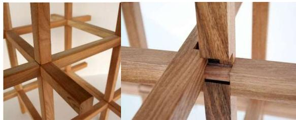
**Gambar 16. Konstruksi kayu *chidori***
