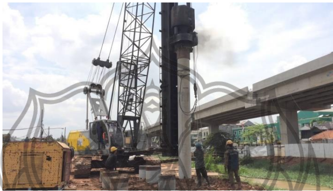
Gb.1. Proses paku bumi konstruksi jembatan Kalimantan
