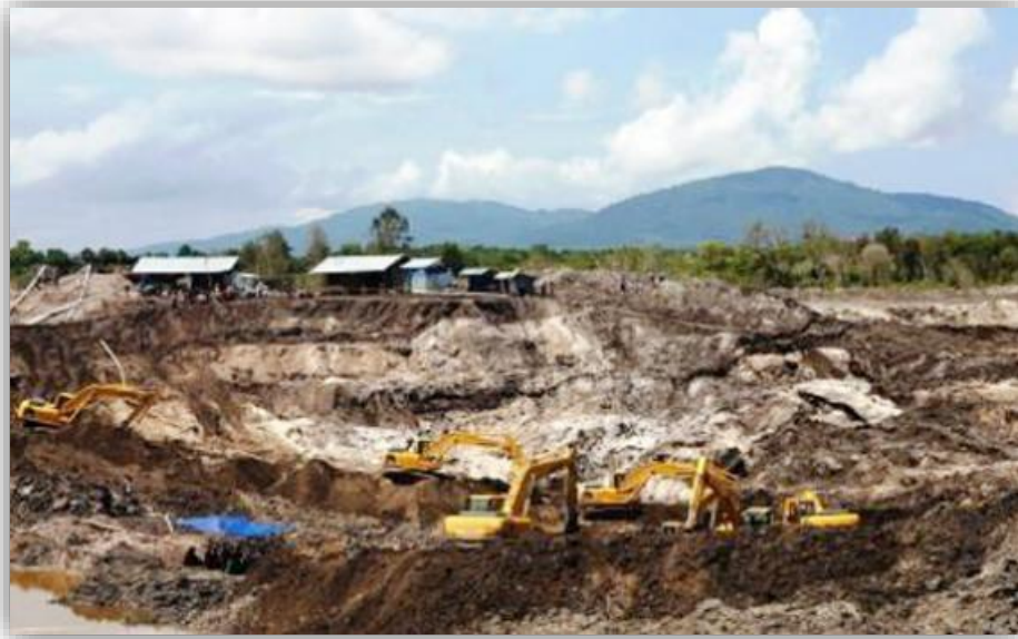
Gambar 4: Kondisi Pertambangan liar yang merusak Lingkungan di Bangka Belitung (Sumber: https://m.tribunnews.com/regional/2014/02/19/polda-babel-akan-berantas-penambang-liar ).
