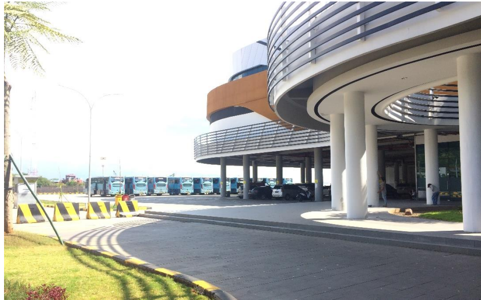
Area Eksterior Pelabuhan Eksekutif Merak Bagian Samping (Sumber : Rutmauli Panjaitan, 2019)
