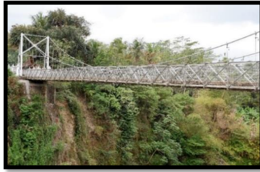
Gambar 3.7. Bentuk Fisik Cagar Budaya Jembatan Gantung Duwet (Sumber: Dok. Anjar Tri Utami, 2018)
